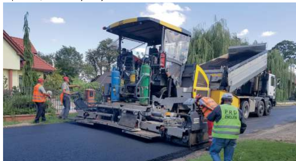
Przebudowa drogi w Długowoli, gm. Lipsko, 2018 r.
