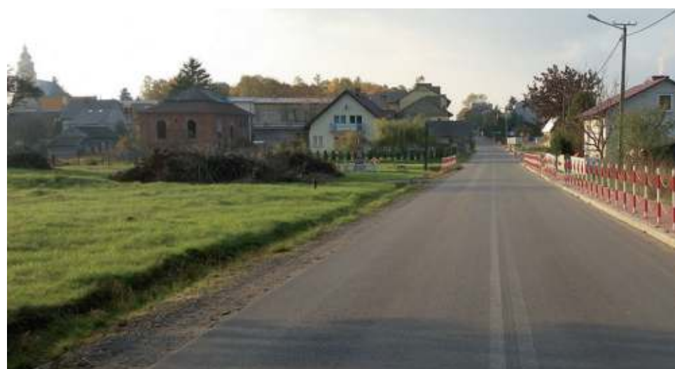
Przebudowana droga powiatowa Ciepeliów-Rekówka z chodnikiem i elementami bezpieczeństwa ruchu drogowego w 2015 r.
