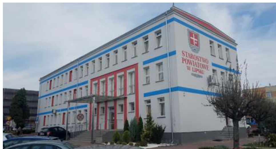
Wyremontowany budynek Starostwa Powiatowego w Lipsku, 2018 r.
